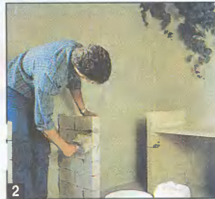
2 Когда раствор затвердеет, поверхности кладки обрабатывают грунтом глубокой пропитки, ...
