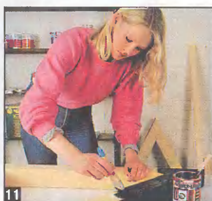
11 Каркас навеса покрывают лазурью (здесь — цвета эбенового дерева) под цвет кафельной плитки.
