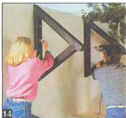
14 Треугольные элементы каркаса навеса крепят к стене на сквозных дюбелях, обычно применяемых для крепления оконных рам.
