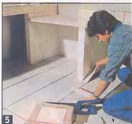
5 Пол кухонного уголка покрывают специальной морозостойкой плиткой, удобной для ухода.
