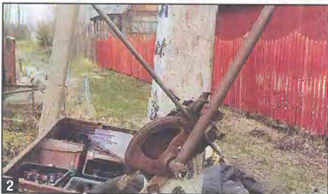
2 Начальная фаза изгиба — трубка заведена под упор и установлена в ручей шкива.
