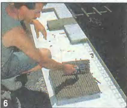
6 Эти дренажные плиты — отличная основа под покрытие пола. Здесь четко виден вставной алюминиевый профиль, ...
