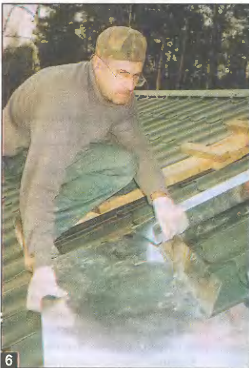
Нижний лист фартука по размерам должен соответствовать ширине трубы и двух боковых листов.
