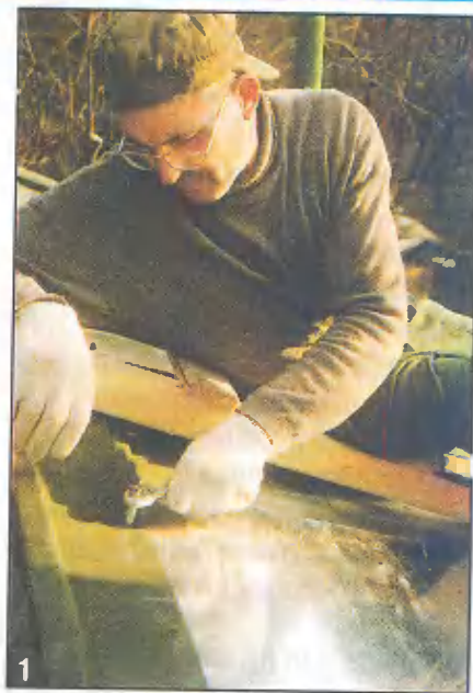
Закрепление листа с помощью кровельных саморезов.
