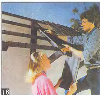
16 Укладку черепицы ведут снизу — вверх, справа — налево. Работу удобно выполнять вдвоем.
