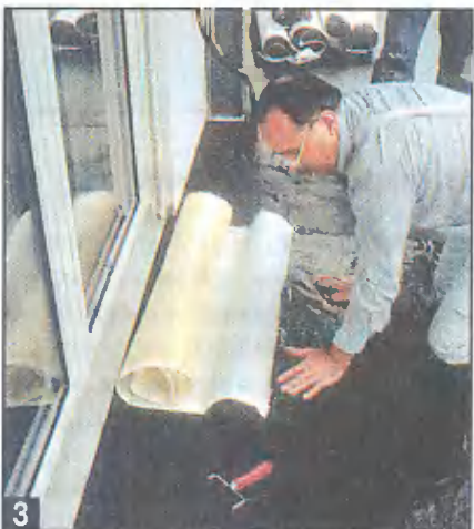
3 Выровненное основание загрунтовали би- тумной массой. Когда масса затвердела (в течение нескольких часов), на основание уложили уплотнительную пленку, ...
