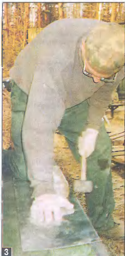
Отбить бортик бокового листа позволяет нехитрое приспособление: металлический уголок, положенный на край садовой скамейки.
