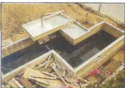
Трубу для подачи воды на самый верхний уровень одели в кожух из ПВХ.
