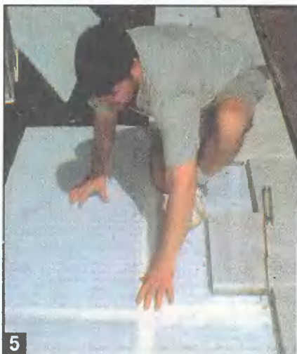
5 Уложили специальные дренажные плиты из твердого пеноматериала, имеющие с одной стороны желобки для стока воды, а с другой — покрытие из водопроницаемо- го нетканого материала, выполняющего функцию фильтра.
