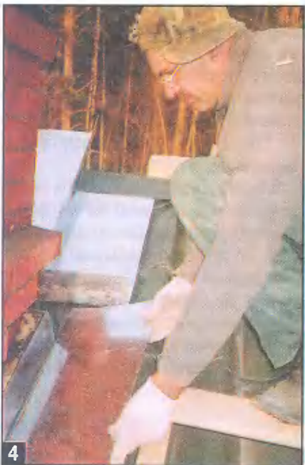
Монтаж бокового листа фартука.
