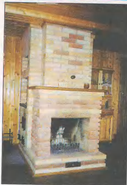
Камин с отопительно-варочной печью из шамотного кирпича в сельском доме. На первый взгляд кажется, что очаг сложили буквально вчера, а не семь лет назад.
