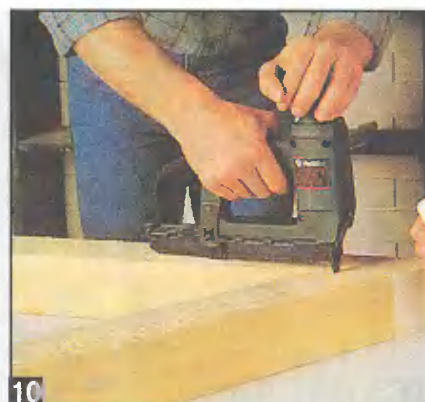
10 Чтобы избежать взаимного смещения соединяемых брусков, их скрепляют скобками с помощью строительного степлера.
