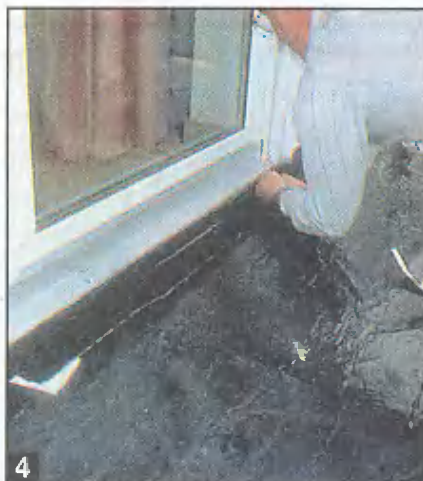
4 ... которую напустили на цоколь до зоны примыкания к дверям. Здесь ее соедини- ли внахлест с кусками такой же пленки и закрепили алюминиевыми профилями.
