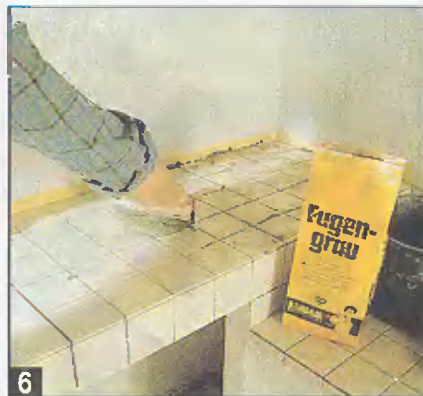
6 Когда клей затвердеет, производят расшивку швов между плитками.
