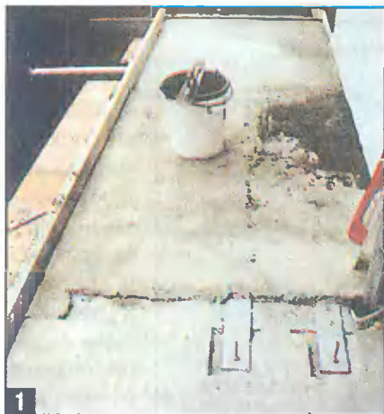
1 Поврежденные места основания пола за- латали цементным раствором.
