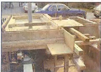
Очень важно, чтобы впоследствии можно было удобно установить опалубку бетонных перегородок пруда.
