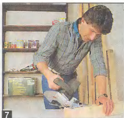
7 Каркас для защитного навеса монтируют из брусков сечением 80х80 мм. Концы их запиливают на скос.
