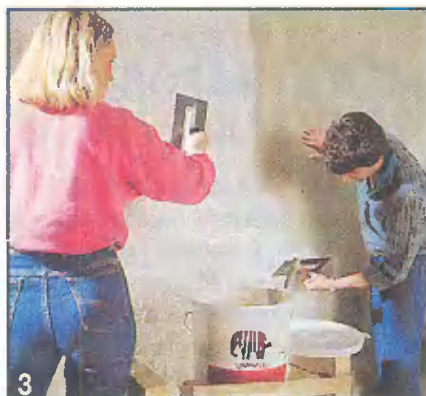
3 ... после чего их вместе со стенами кухни оштукатуривают «под рустику».
