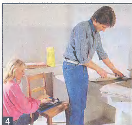
4 На предварительно зашлифованные плиты наносят тонким слоем толщиной 25 мм эластичный клей и укладывают кафельные плитки.
