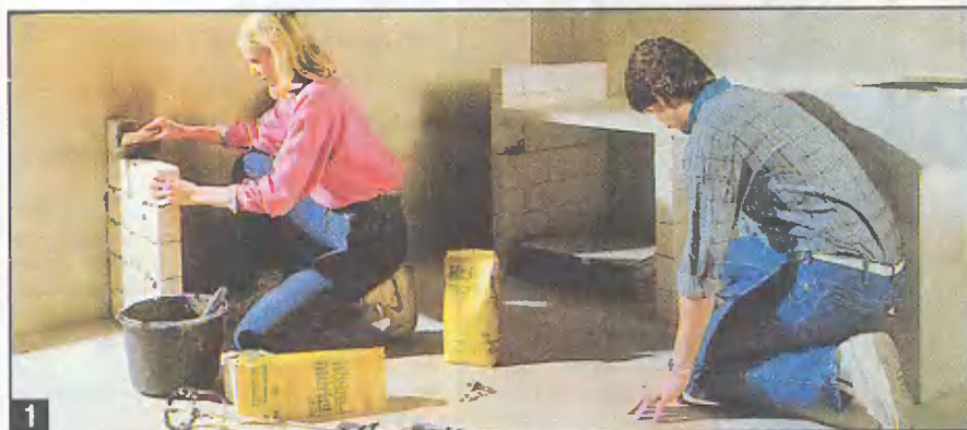
1 Сначала из газобетонных блоков и силикатных кирпичей возводят кладку под кухонные рабочие плиты и фасадные поверхности, которые сделаны из водостойкой ДСП толщиной 25 мм.
