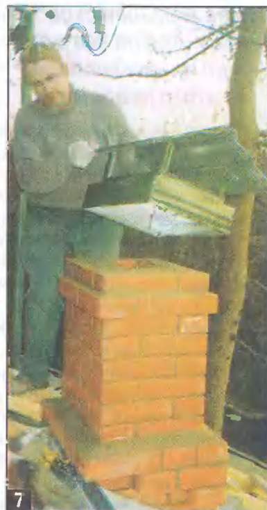
Последний штрих: крепление колпака на дымовую трубу.
